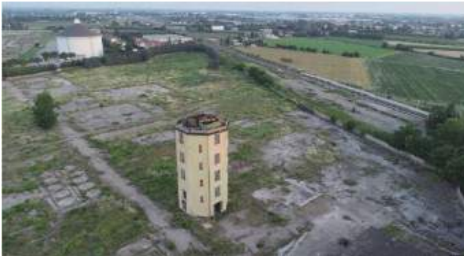
Vista aerea della torre esagonale successivamente alle opere di demolizione
