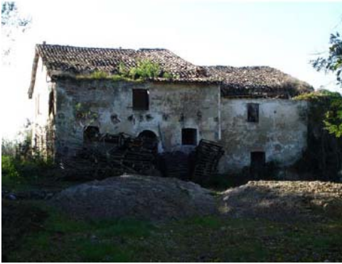
Foto edificio scheda 619
