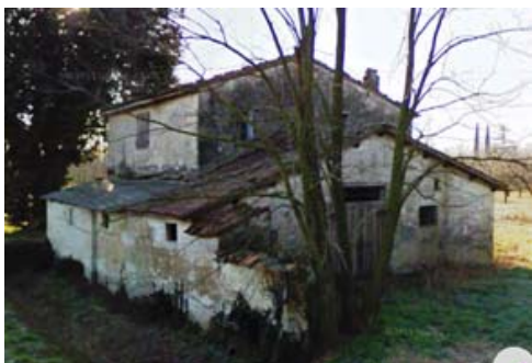
Foto edificio scheda 145
