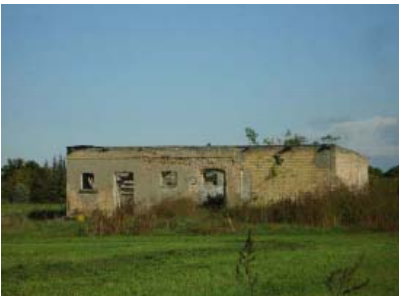
Foto edificio scheda 618
