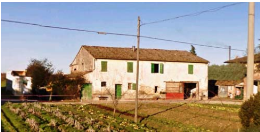
Foto edificio scheda 46
