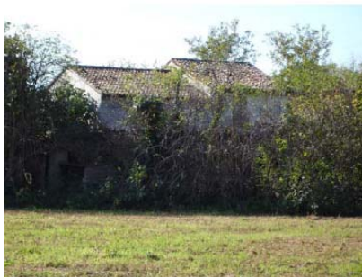
Foto edificio scheda 301
