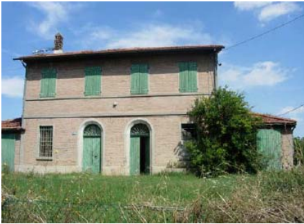
Foto edificio scheda 69
