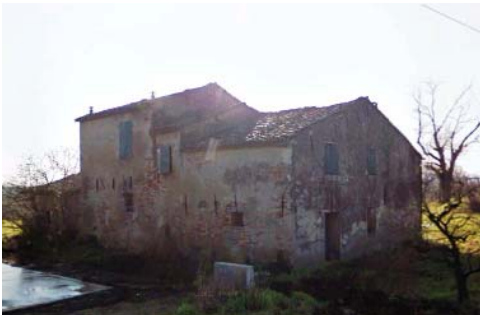
Foto edificio scheda 78
