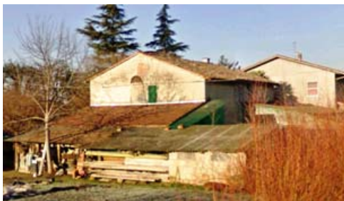
Foto edificio scheda 141
