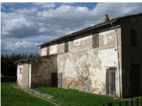
Foto edificio scheda 322
