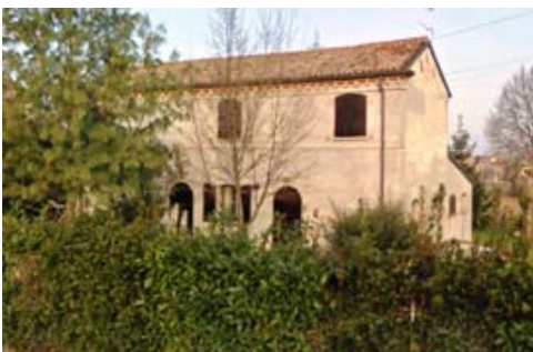
Foto edificio scheda 95
