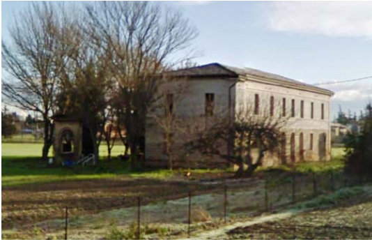
Foto edificio scheda 238
