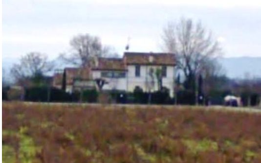
Foto edificio scheda 250
