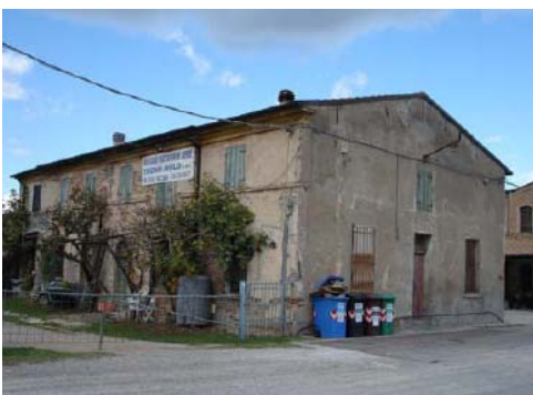
Foto edificio scheda 634
