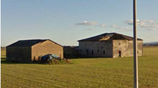
Foto edificio scheda 2
