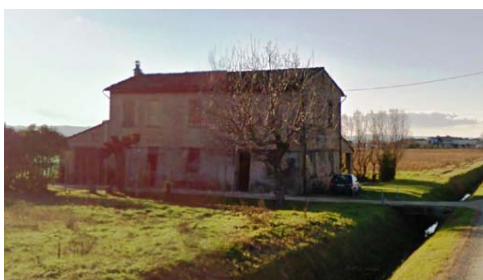
Foto edificio scheda 386
