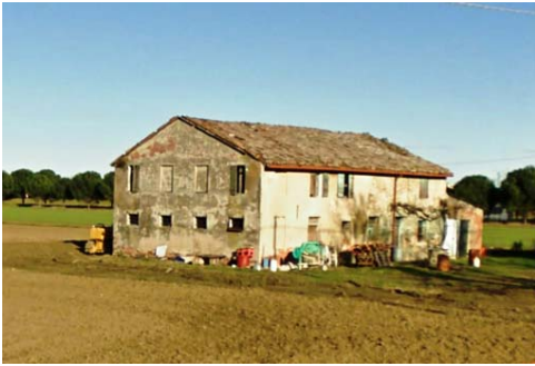
Foto edificio scheda 417
