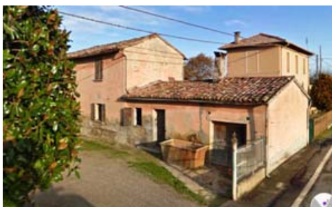
Foto edificio scheda 132
