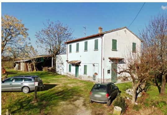
Foto edificio scheda 571
