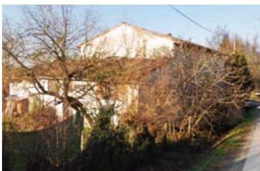
Foto edificio scheda 149
