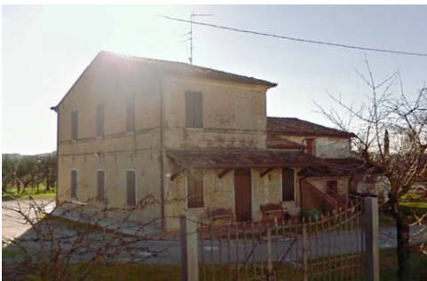
Foto edificio scheda 412
