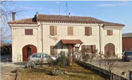
Foto edificio scheda 225
