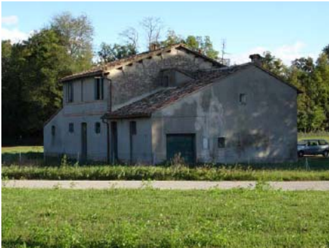
Foto edificio scheda 645
