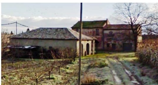
Foto edificio scheda 168
