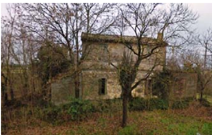
Foto edificio scheda 665
